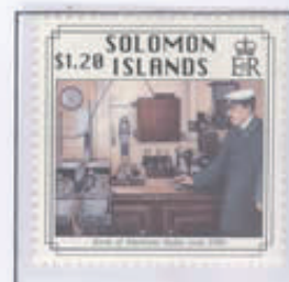
Stazione radio Marconi installata su una nave (1900)
