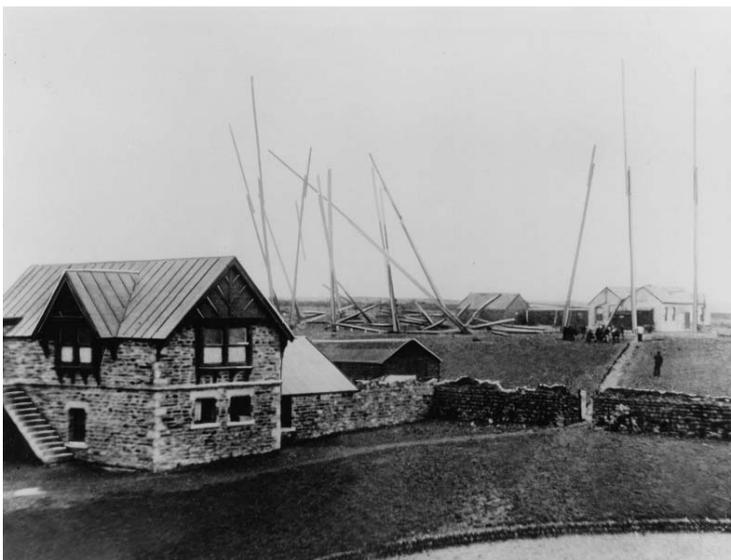
*La stazione di Poldhu con la nuova antenna, più semplice e robusta, costituita da due piloni alti 45 metri che sostengono 55 fili convergenti, a forma di ventaglio, nell'edificio che contiene gli apparati radio trasmettenti.*
