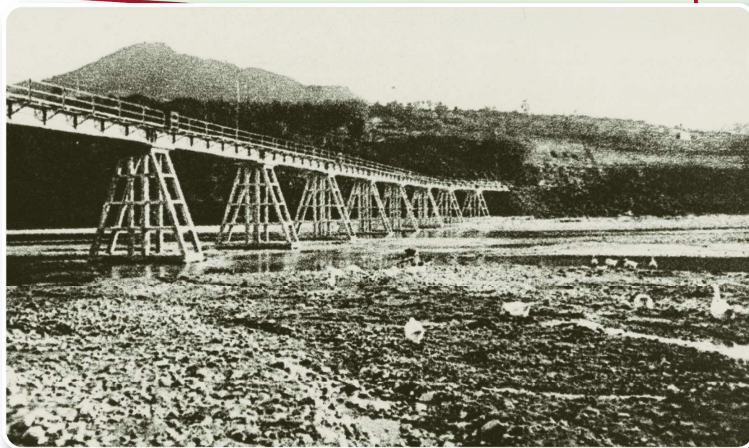
Sasso - Attraversamento sul fiume Reno su stilate di cemento armato.
