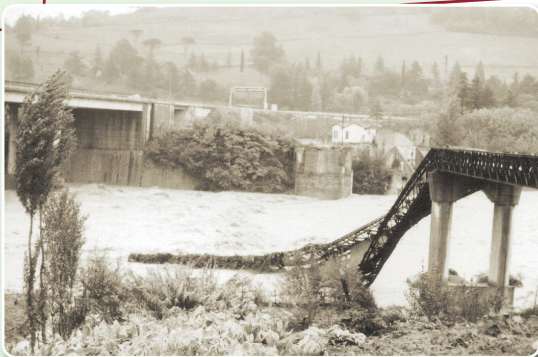
Sasso Marconi - 6 novembre 1966. La piena ha distrutto il Ponte Albano. (foto di Arrigo Lamma).
