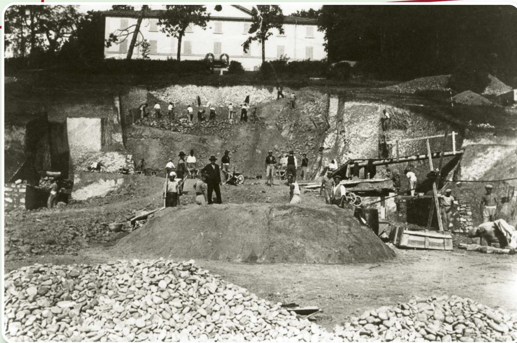
Pontecchio Marconi - Foto del 7 agosto 1940. Lavori per la costruzione del Mausoleo di Marconi (foto di Bignami Valerio, archivio U. Guidoreni).
