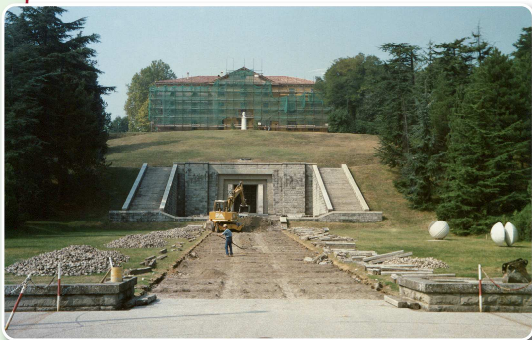
Pontecchio Marconi - Ristrutturazione del Mausoleo Marconi e Villa Griffone.
