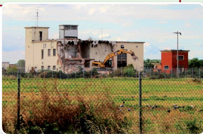
26/06/2013 - Stazione trasmittente Rai di Budrio - La ruspa inizia la demolizione della Palazzina Marconi (Foto Budrio Next - dal sito www.Radiomarconi.com )
