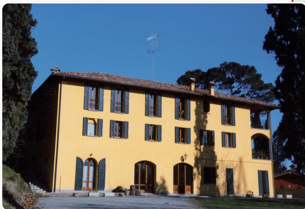
Sasso Marconi - Un paese che cambia. Edificio totalmente ristrutturato di via Santa Liberata 8.
