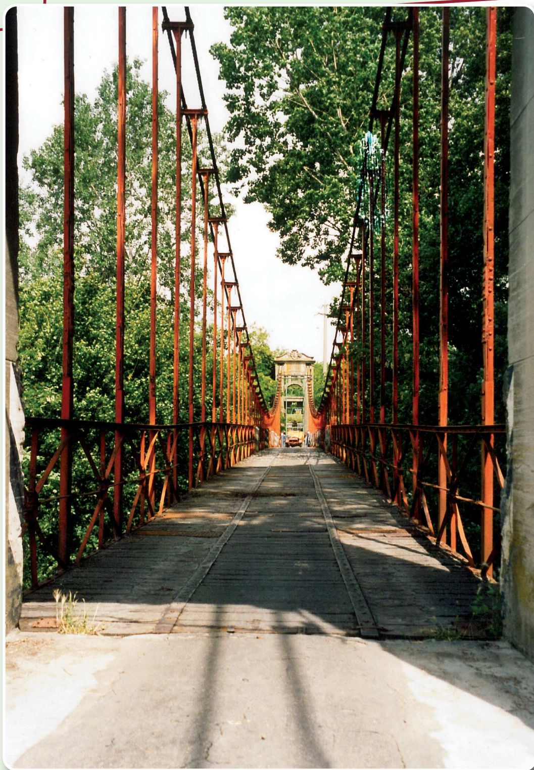
Bella foto del ponte di Vizzano (foto B. Piccinelli).
