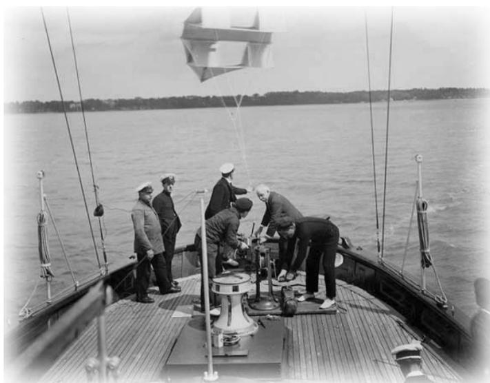
*Esperimenti con un cervo volante (antenna a forma di aquilone) a bordo dell'*Elettora**
