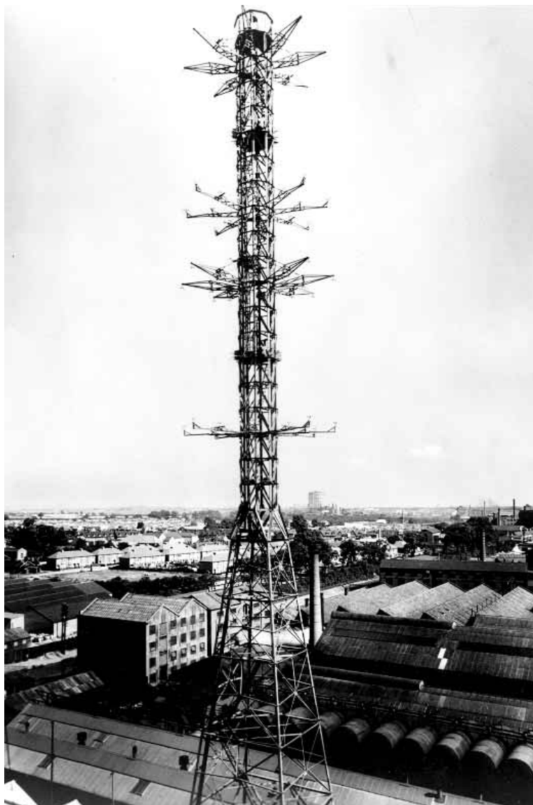
Fig. 128 - Antenna TV Marconi-EMI, installata ad Hayes, nel Middlesex.
