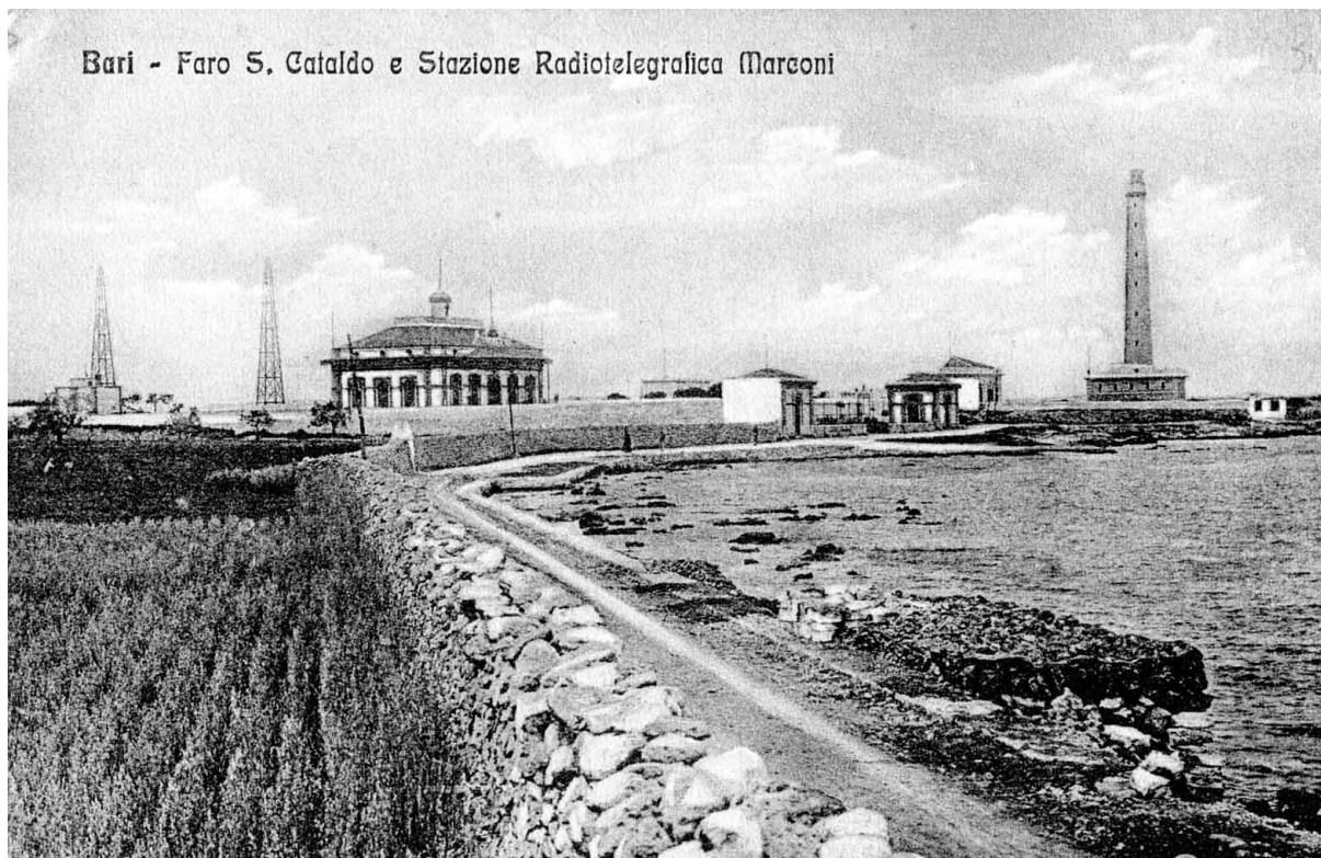
Fig. 82 - La stazione di Bari San Cataldo nel 1904 esegue il primo collegamento di servizio pubblico con la stazione radio di Antivari, l'attuale Bar, in Montenegro.
