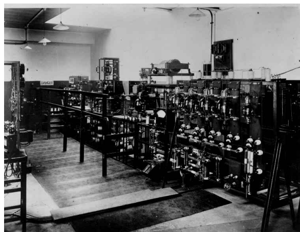
Fig. 115 - Apparecchi della stazione radio 2-LO nella Marconi House di Londra.
