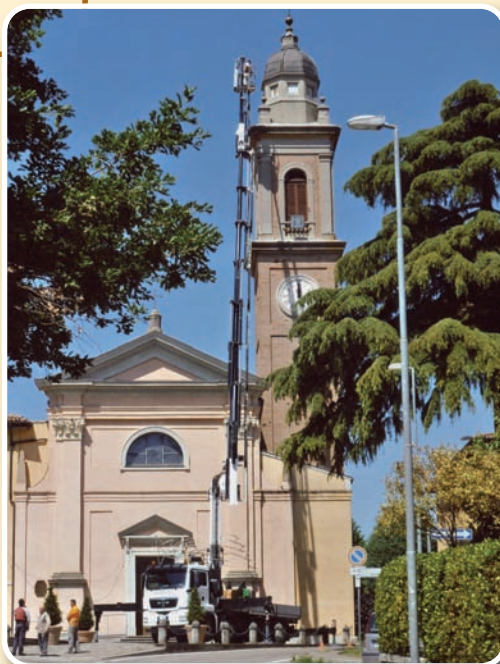
Pontecchio Marconi - 17 maggio 2012. Manutenzione al campanile eseguita dalla ditta Bendini di Marzabotto.
