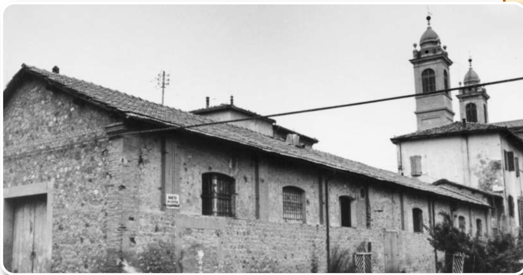
Sasso - 1915. Edificio realizzato nel 1887 per la nuova tessitoria, ma non venne mai utilizzato per questo scopo. Dagli anni '30 venne adibito a cinema, oggi teatro.
